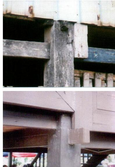
Gambar 12. Sistem Sambungan Balok Lantai dan Tiang
